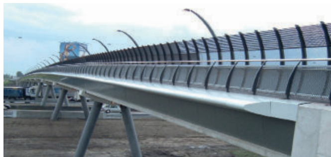
Bridge Leidschenveen, Den Haag
